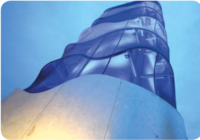
Illumination des neuen Wahrzeichens in Drispensstedt: Der Wärmespeicher der EVI
